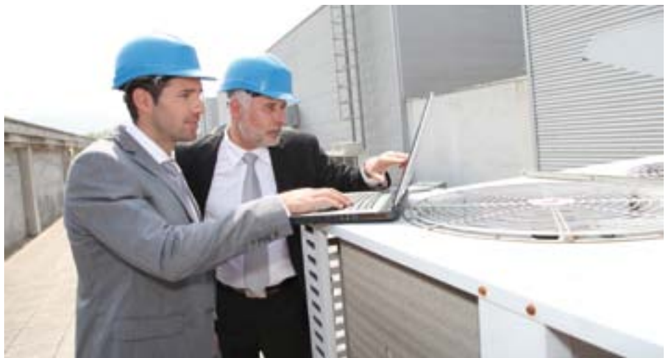
Sämtliche Anlagenkomponenten werden bei der energetischen Inspektion überprüft
